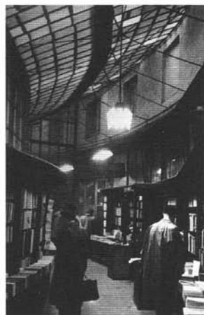
Vue de la verrière, ramenée à un seul versant dans la partie en arc-de-cercle épousant le contour du marché.
