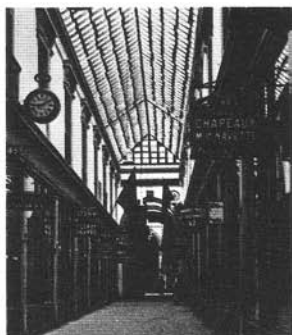
Le passage Lemonnier, à Liège, reprend l'élévation à deux niveaux du passage parisien sous verrière à deux versants.
