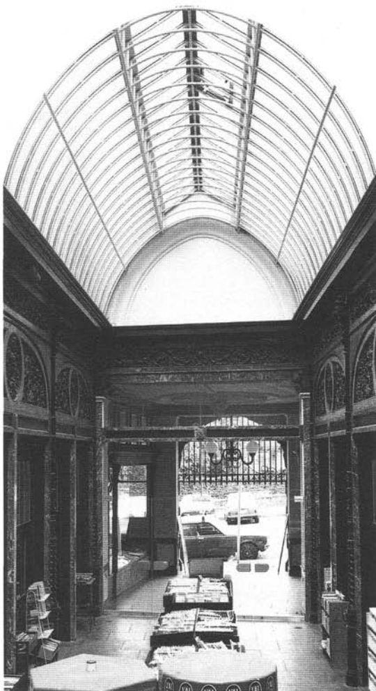
La verrière repose sur des arceaux en tube d'acier.
