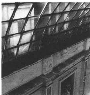
Le niveau des mansardes, derrière la verrière.
