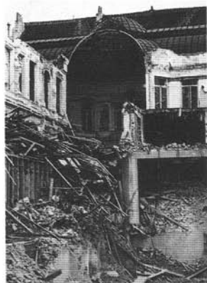
La galerie du Commerce et le reste de sa verrière.
