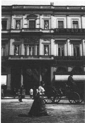
Façade externe des galeries.
