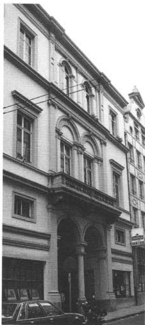
Façade rue Saint-Jean.
