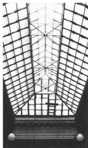
La verrière du passage du Prince.
