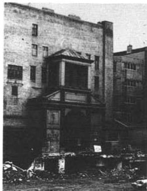
Le passage des Postes en cours de démolition. Vue sur le portail postérieur.
