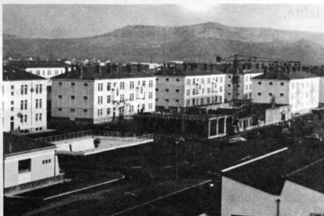
Construction du foyer
