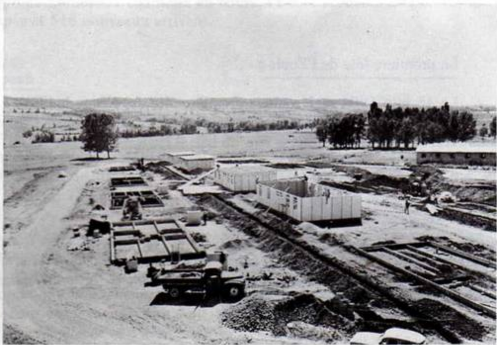
Construction de la cité cadre l'ancienne «Cité du Château»
