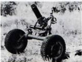
çaise et différentes armées étrangères, le mortier rayé de 120 mm supporte avantageusement la comparaison avec les canons et obusiers classiques déjà en service.
