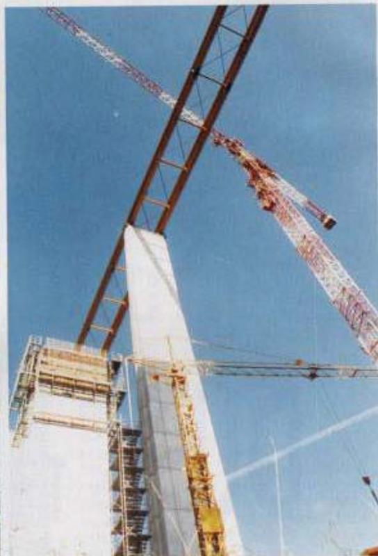
Ces poutres, d'un poids total de 2 000 tonnes, reposent sur un ensemble de 18 piles dont les plus grandes font 75 m. Le pont fini pèsera la bagatelle de 40 000 tonnes, soit environ quatre fois et demi le poids de la Tour Eiffel.
