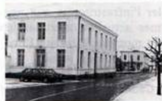
Bâtiment PC et SG.
