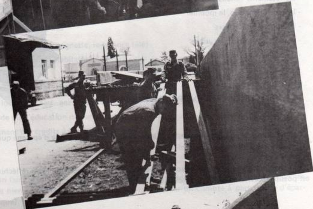
Montage de la rampe d'accès.
