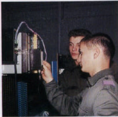
La réalisation des panneaux de câblages demande soins et esthétique.
